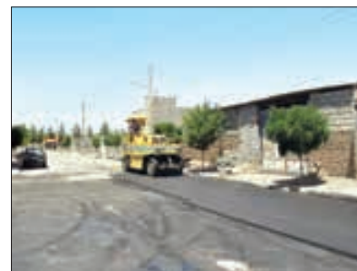
آماده سازی آسفالت کوچه آزادگان ۱۳
