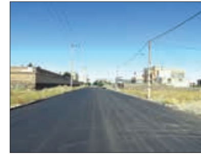
آماده سازی آسفالت خیابان دانش آموز
