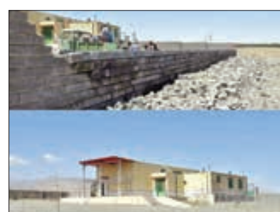
اجرای دیوار کشتارگاه
