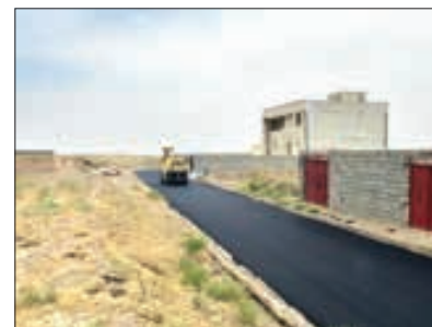
آماده سازی آسفالت کوچه امام خمینی (ره) ۱۵
