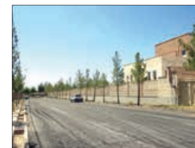
آماده سازی آسفالت خیابان ۷ تیر
