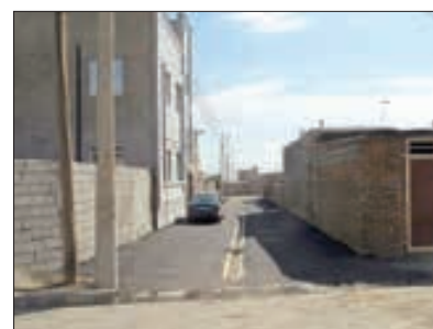
آماده سازی و آسفالت کوچه شبینم
