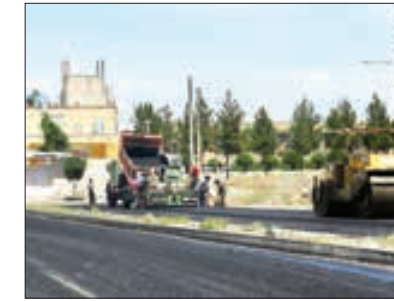
آماده سازی آسفالت بلوار ۱۳ آبان
