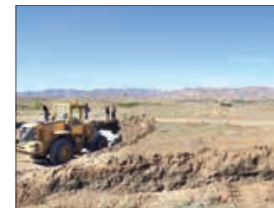
خاکبرداری از ترمینال
