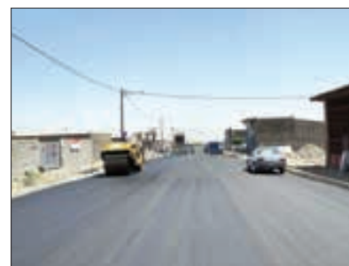
آماده سازی آسفالت خیابان صنعتگران
