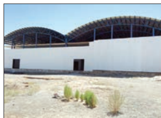
سردخانه چند منظوره کارخانه یخ دنیز-۹۶
