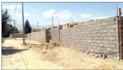
احداث دیوار بلوک سیمانی در معابر عقب نشینی شده سطح شهر
