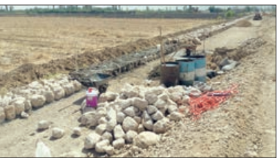
زیرسازی و لاشه چینی با سنگ جهت اجرای آبی جوی در مسیر بولوار کشاورز
