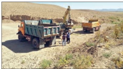
بارگیری و حمل مصالح از معدن جهت زیرسازی معابر سطح شهر
