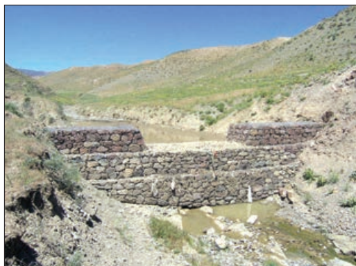
عملیات آبخیزداری بند خاکی برده، گابیون بندی در شهرستان و همچنین عملیات نقشه برداری بند خاکی خلیج
