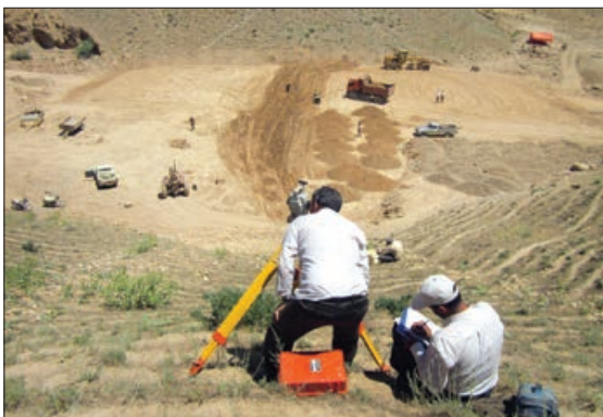
عملیات آبخیزداری بند خاکی برده، گابیون بندی در شهرستان و همچنین عملیات نقشه برداری بند خاکی خلیج
